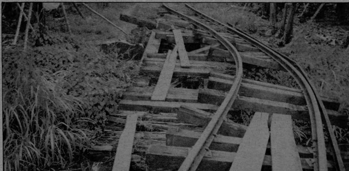
El transporte de fruta por ferrocarril quedó interrumpido. Más de 20 kilómetros de vía quedaron destruidos.
